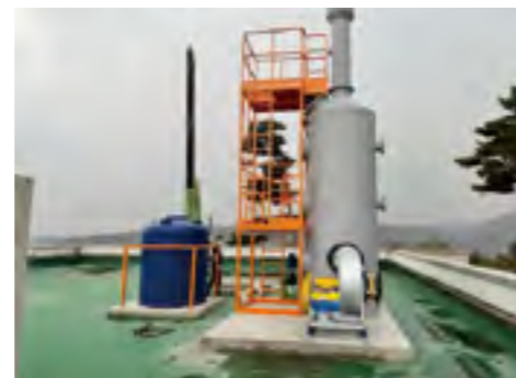
대기오염물질 방지시설, 스크러버 설치
