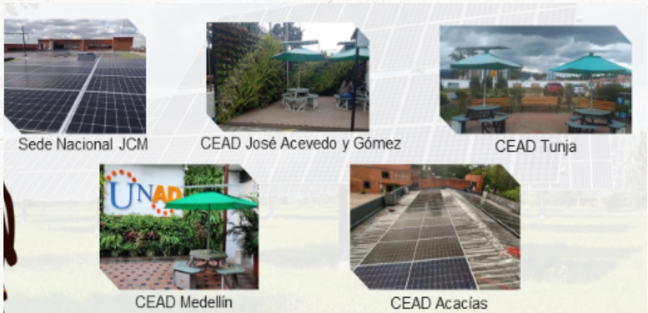
Figura 14. Paneles solares fotovoltaicos en la UNAD 2023.
