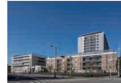
兵庫県立はりま姫路総合医療センター 【給排水衛生設備工事】
