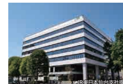
JR東日本仙台支社 【空調設備工事】
