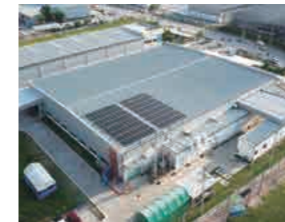
タイ 既存工場に太陽光電池設置 (三重精機)
