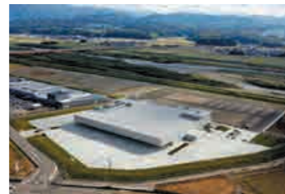
伸晃化学川北工場 【空調・給排水衛生設備工事】
