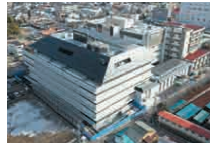
上田市新本庁舎 【空調・給排水衛生設備工事】
