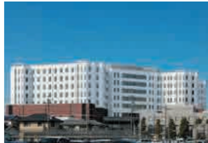
小牧市民病院 【空調・給排水衛生設備工事】
