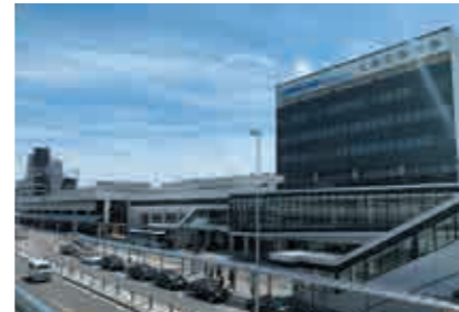
大阪国際空港ターミナルビル改修 【給排水衛生設備工事】
