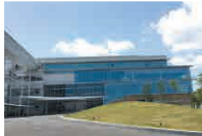
AGC横浜テクニカルセンターSE1棟 【空調・給排水衛生設備工事】
