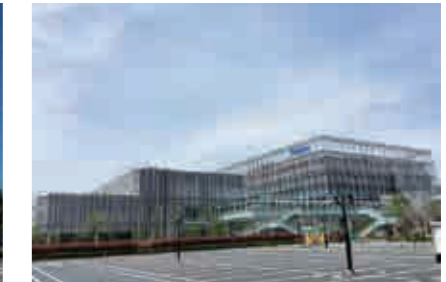
Kurita Innovation Hub (東京都) 【電気設備工事】
