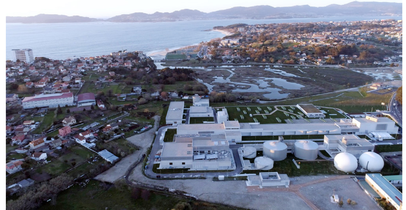
Estación Depuradora de Aguas Residuales (EDAR) Lagares, Vigo, Pontevedra, España.
