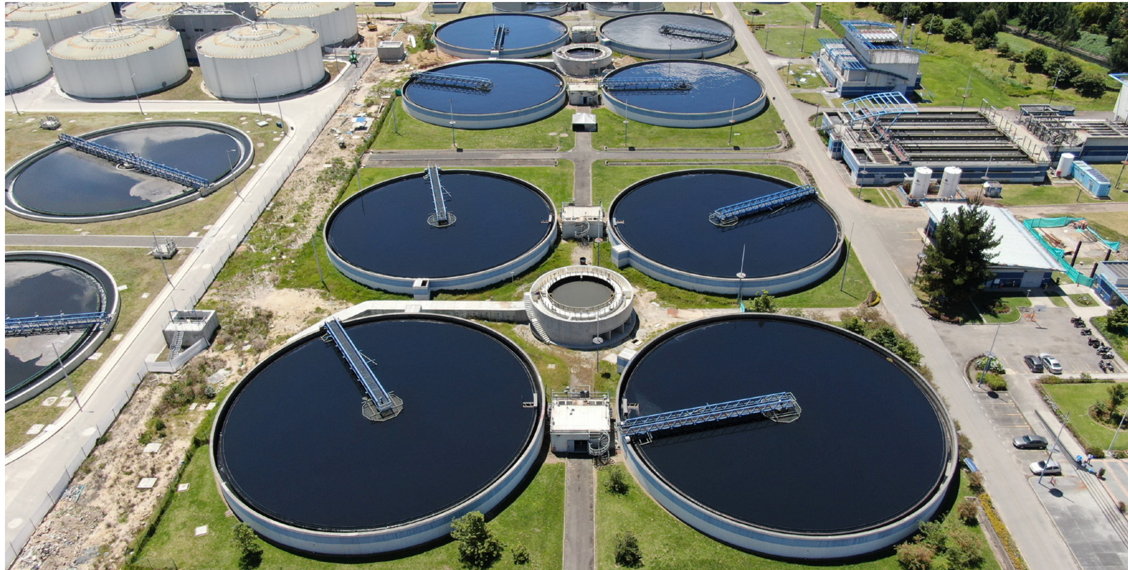
Estación Depuradora de Aguas Residuales (EDAR) El Salitre, Bogotá, Colombia.
