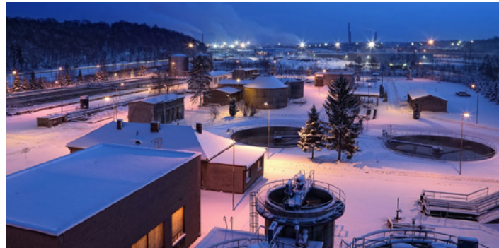
Estación Depuradora de Aguas Residuales (EDAR) de Trinec, distrito de Frýdek-Místek de la región de Moravia-Silesia, República Checa.
