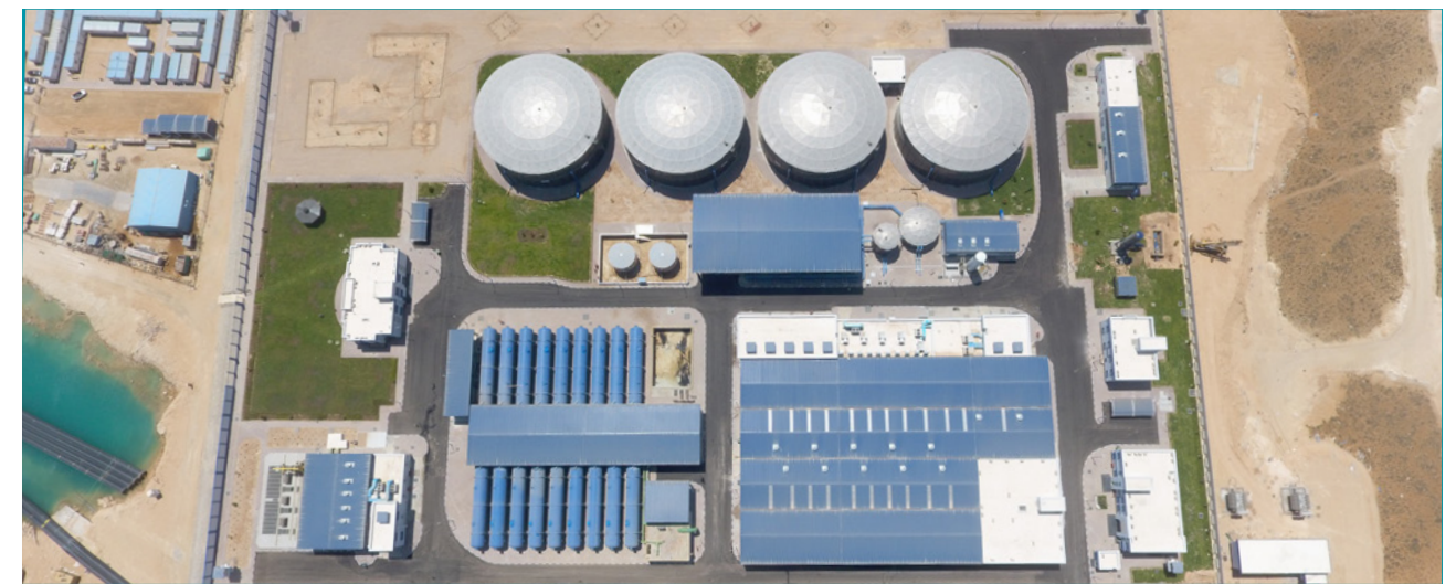
Instalación Desaladora de Agua del Mar (IDAM), El Alamein, Egipto.
