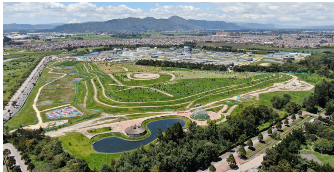
Parque Metropolitano de la Estación Depuradora de Aguas Residuales El Salitre, Bogotá, Colombia.
