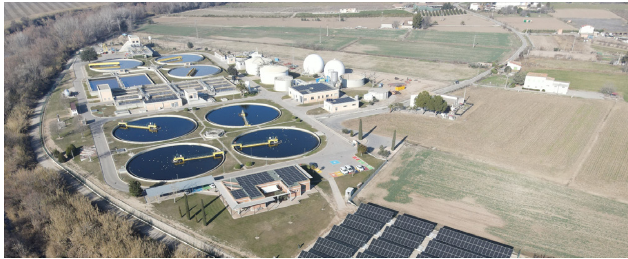
Estación Depuradora de Aguas Residuales (EDAR) de Lleida, Cataluña, España.
