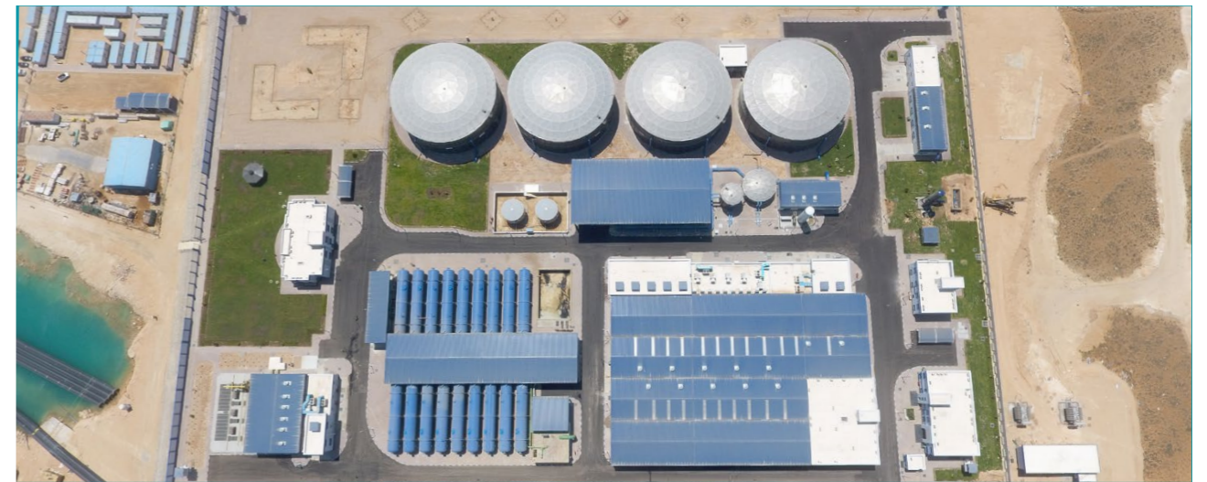
Sea Water Desalination Plant (SWDP) El Alamein, Egypt.
