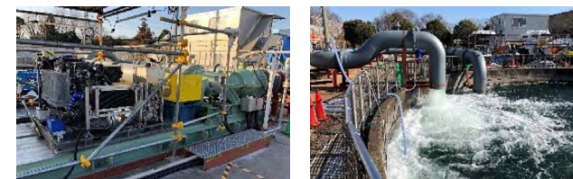
『デリカD:5』用エンジンを動力源として排水ポンプを駆動 実証試験時の排水の様子
