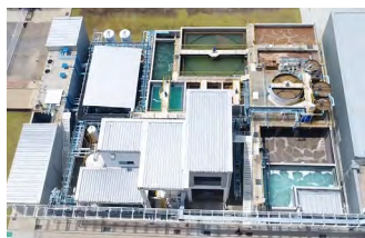
排水リサイクルプラント (MMTh)
