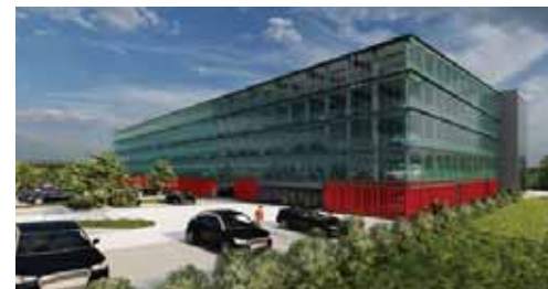
In das neue Parkhaus werden viele Aspekte der Nachhaltigkeit integriert.
