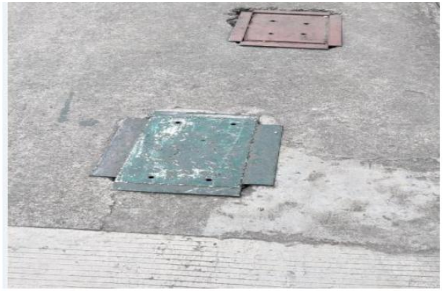
(图 生活污水下水道连接市政管道)
