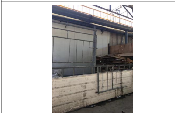
一般固废暂存场所
