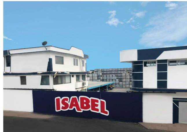
Fábrica Manta. Ecuador.
