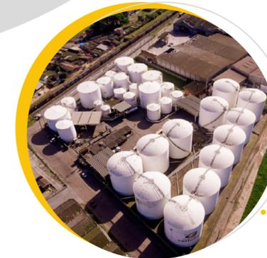
**CT2:** 90.000 m<sup>3</sup>; 29 tanques com estrutura para produtos aquecidos; 12 baias para carga e descarga de caminhões; descarregamento para 18 vagões
