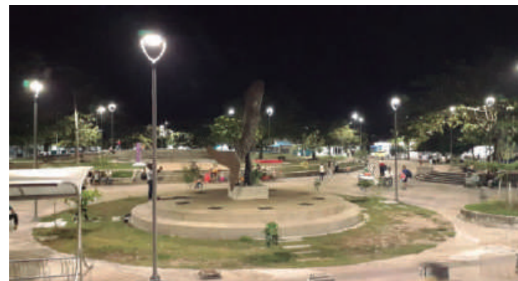
Modernización alumbrado público de La Dorada (Caldas)
