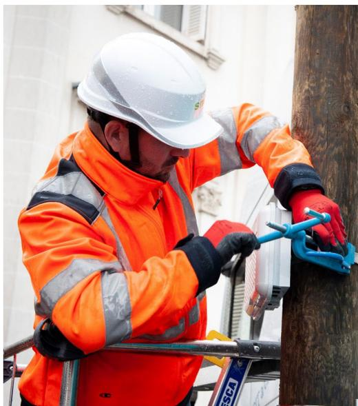
Tirage aérien de la fibre par un raccordeur de fibre
