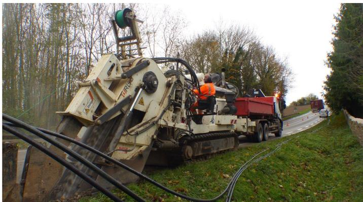
Travaux de tranchée pour la pose des fourreaux nécessaires au transport et à la distribution.
