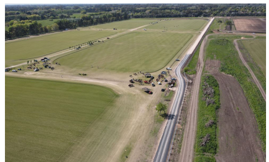
AAP Pilar | Nuevo Camino ASFALTADO (recorrido traza)
