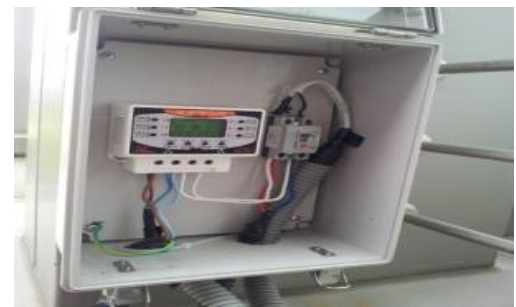
간편 타이머 설치
