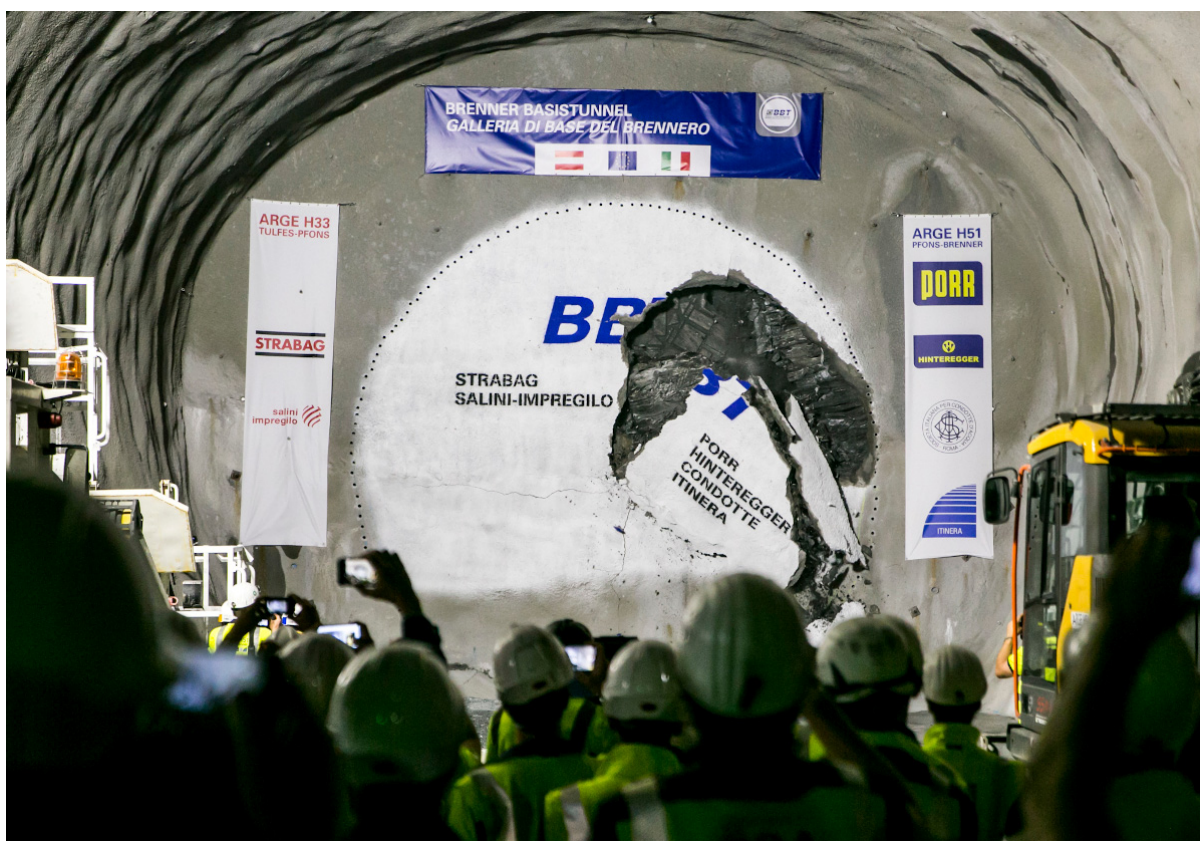
Figura 18: Cerimonia per l'abbattimento del diaframma nel cunicolo esplorativo tra i cantieri di Ahrental e Wolf (Austria)
