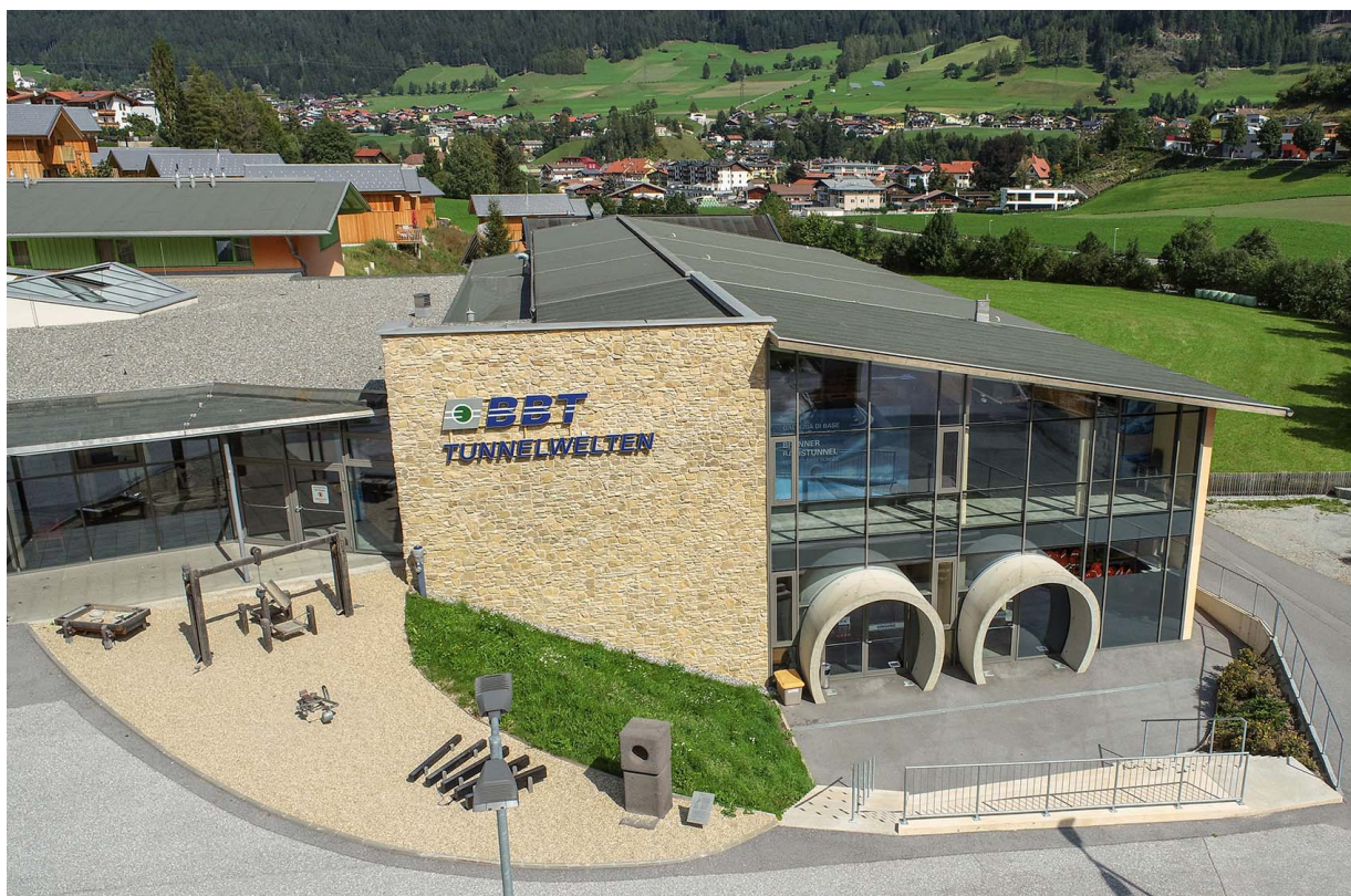
Figura 10: Infopoint BBT „Tunnelwelten“ presso Steinach am Brenner (Austria)
