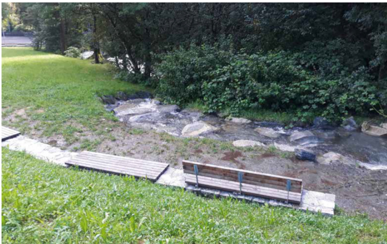
Figura 16: Interventi spondali Rio di Scaleres presso la località Varna
