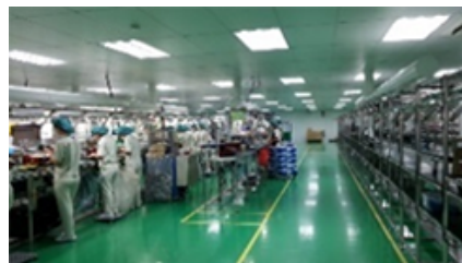
カシオタイ工場のLED照明
