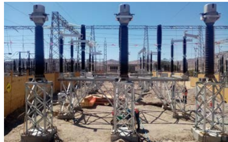
Trabajos de Pine SpA en la subestación Diego de Almagro
