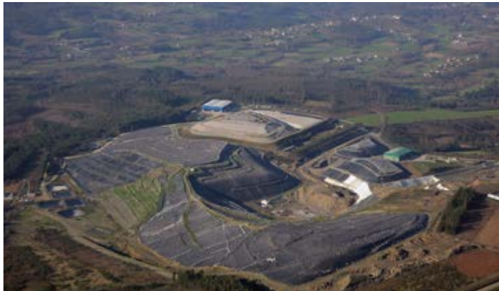
Vertedero de residuos no peligrosos- Cerceda
