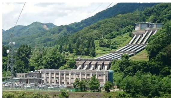
再生可能エネルギー由来電力を供給する水力発電所
