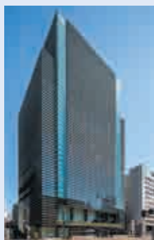
ひろぎん ホールディングス 本社ビル 【空調設備工事】
