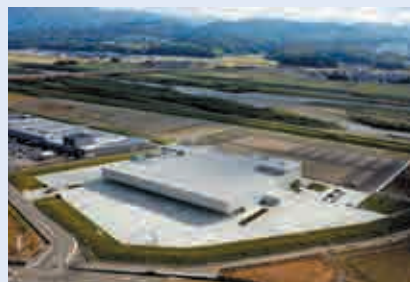
伸晃化学川北工場 【空調・給排水衛生設備工事】
