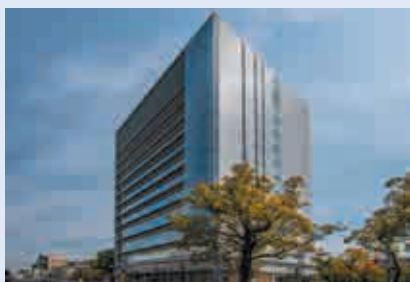
西宮市第二庁舎 【空調・給排水衛生設備工事】
