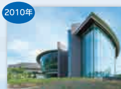
2010年 沖縄科学技術大学院大学 研究棟センター棟 [沖縄]
