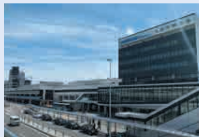
大阪国際空港ターミナルビル改修 【給排水衛生設備工事】
