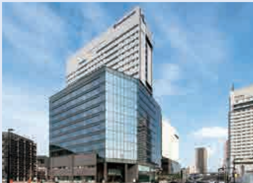
GRANODE広島 【電気・空調・給排水衛生設備工事】
