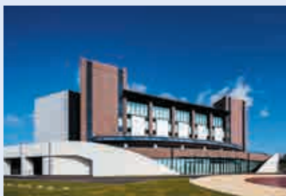
沖縄アリーナ 【空調設備工事】
