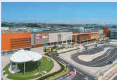
ららぽーと愛知東郷 【電気設備工事】
