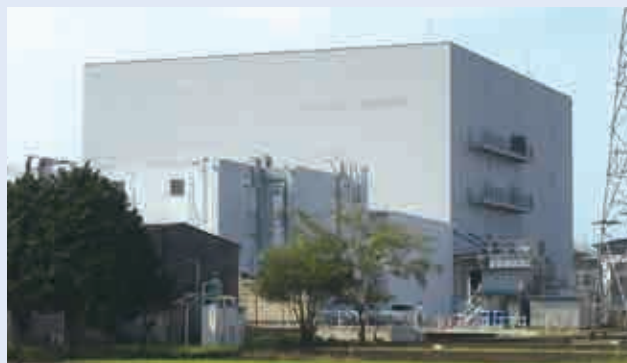
東海カプセル株式会社 本社工場 【空調・給排水衛生設備工事】
