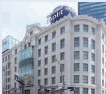
南海電気鉄道株式会社 南海ターミナルビル 【電気設備工事】
