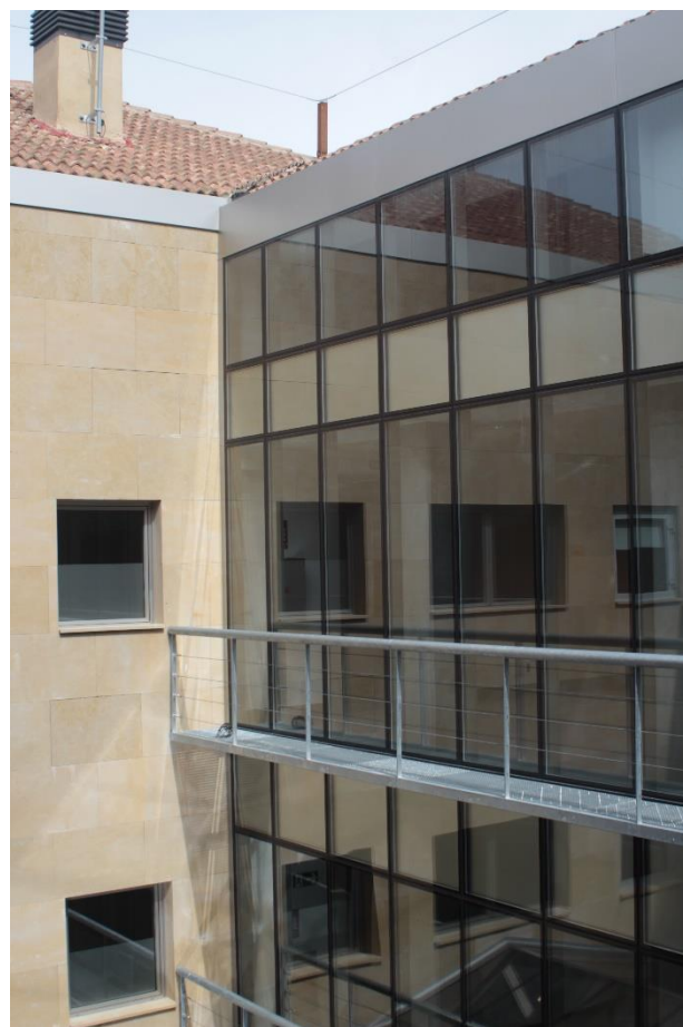
Rehabilitación de las antiguas sedes del Banco de España – Vitoria
