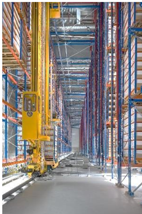
Silo del CADA
