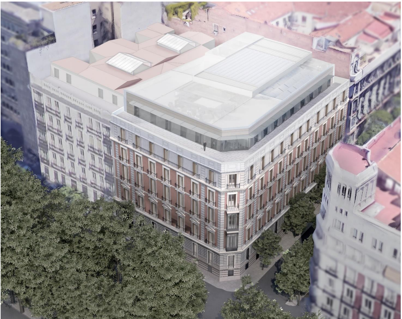
Obras de Rehabilitación del Edificio en Pº de la Castellana 14, para el Consorcio de Compensación de Seguros
