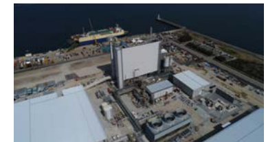
伏木万葉埠頭バイオマス発電所
