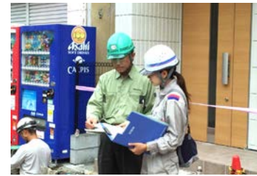
導管工事現場での業務にあたる女性社員
