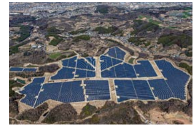
関東圏内最大級の発電容量を有する安中市太陽光発電所の様子
