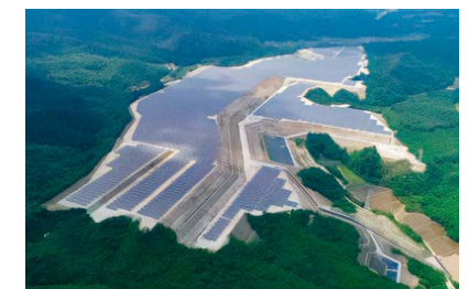
宮城県・黒川メガローラー発電所
