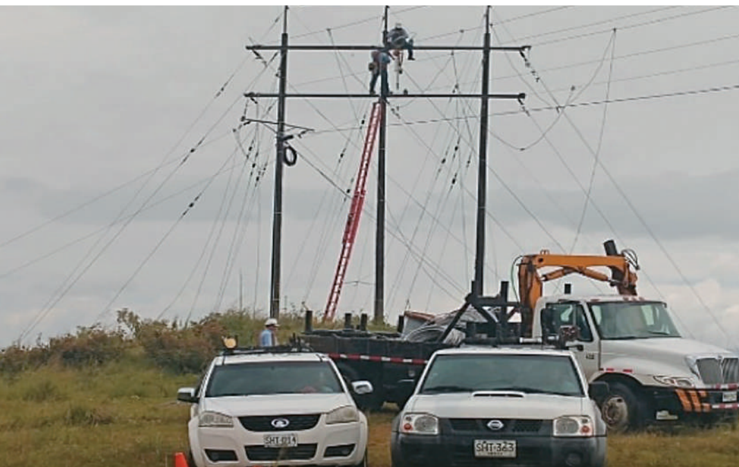
Reubicación de 1 kilómetro de la red la línea principal Tambo. Hincada de postes 14 mts.
