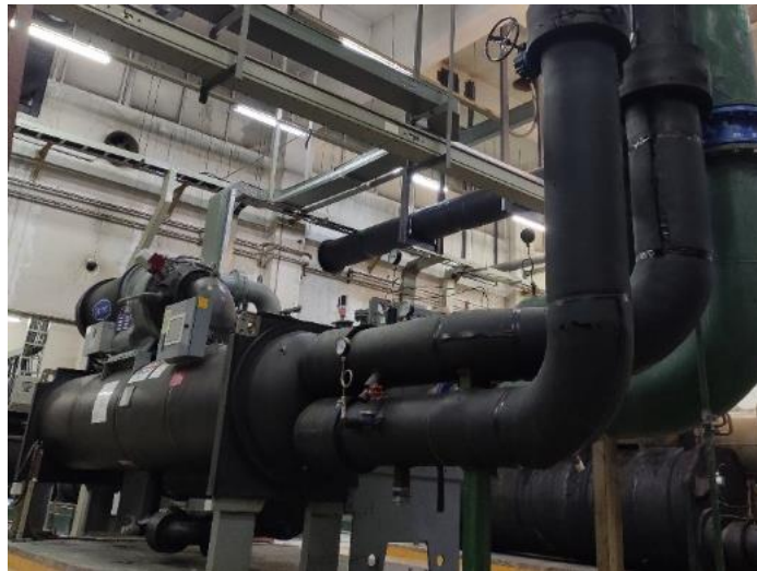
制冷站管道改造
