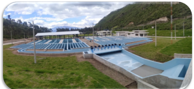
Ampliación de la Planta de Tratamiento Paluguillo - Parroquias Orientales
