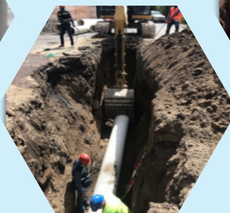
Extensión de redes de alcantarillado varios sectores de la parroquia Tumbaco, grupo 2
