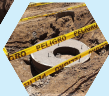
Alcantarillado combinado para los barrios Altos de La Argelia, 3ra. Etapa, parroquia La Argelia.
