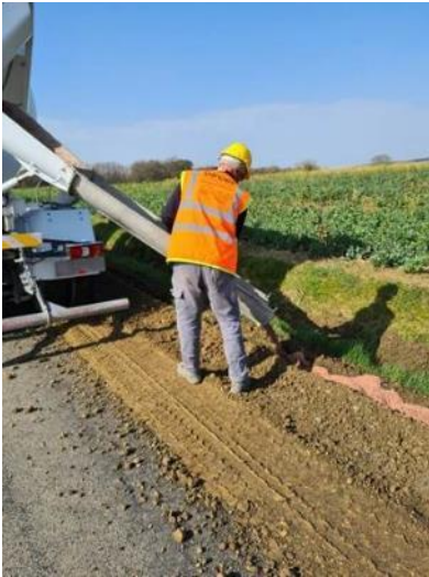
Travaux de tranchée pour le réseau de collecte
