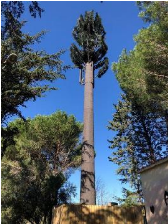
Pylône arbre implanté à proximité d'une église romane classée aux monuments historiques
