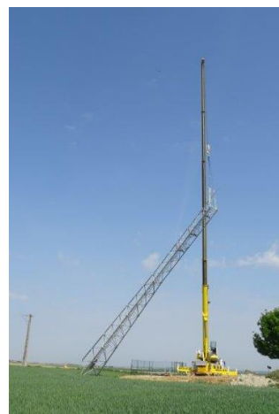
Levage d'un pylône treillis en Seine-et-Marne
