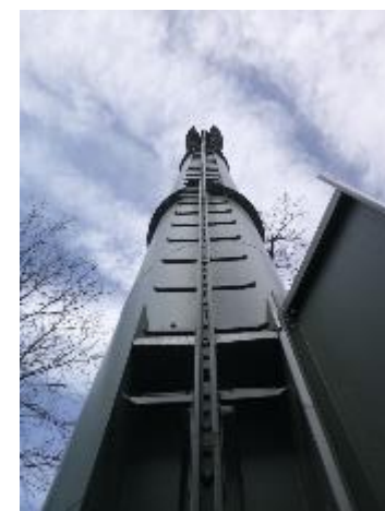
Levage d'un pylône monotube dans le Sud-Ouest
