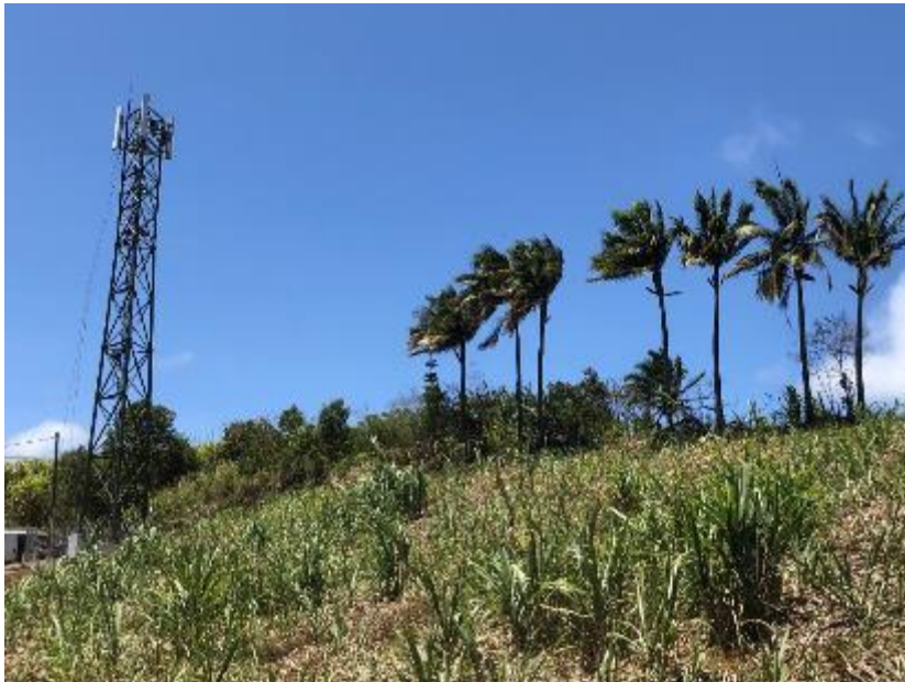
Levage de pylône sur « Petite Ile » - La Réunion, octobre 2020
