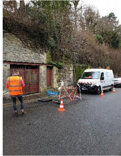
Passage de la fibre en sous-terrain
