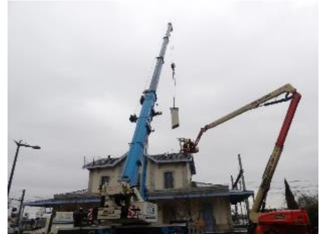
Pose d'une fausse cheminée pour l'intégration d'une antenne
