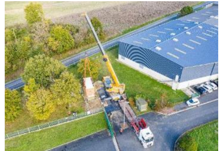
Grutage & pose d'un nœud de raccordement optique (NRO), étape importante avant la commercialisation
