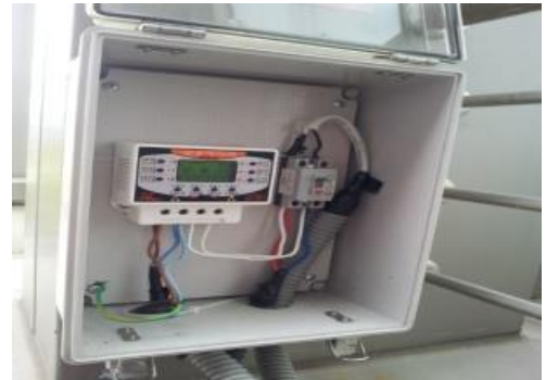
간판 타이머 설치
