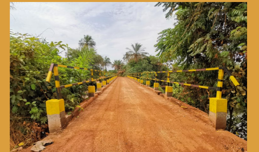
中铝几内亚支援基础建设，修复巴克洛桥梁
