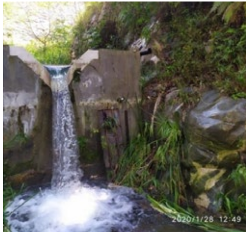
Figura 7. Vertedero Triangular para la medición de los caudales de infiltración
