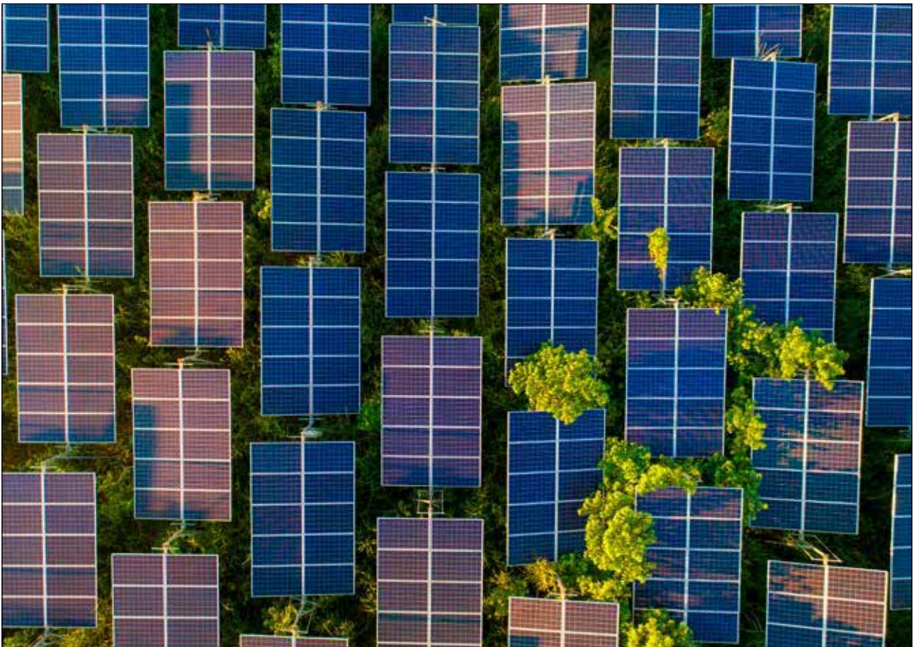
Paneles fotovoltaicos fabricados con componentes de acero inoxidable.
