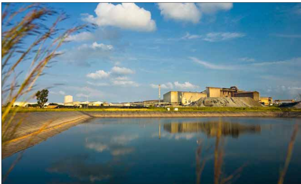
Embalse para almacenamiento de aguas pluviales en la factoría de Columbus.
