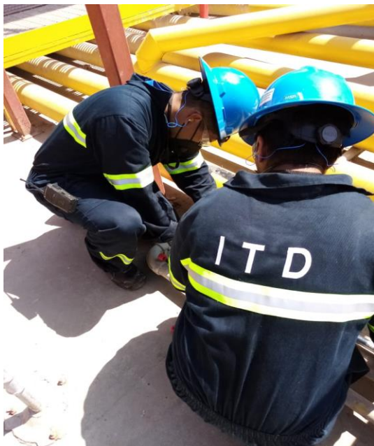
Imagen 4. Colocación de tubería para instalación eléctrica, Halliburton
