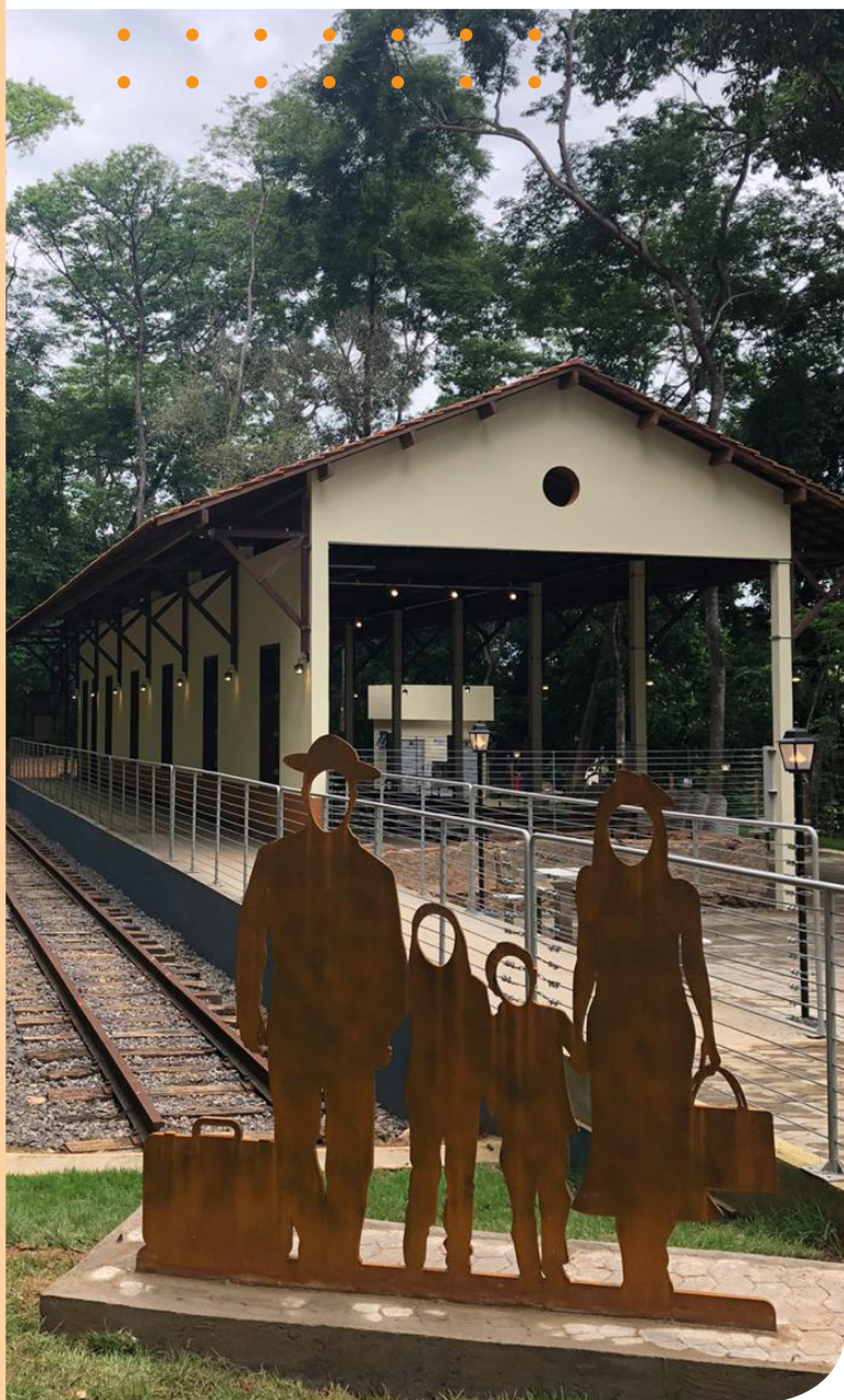
Estação Pedra Mole, restaurada pela Usiminas, em Ipatinga
