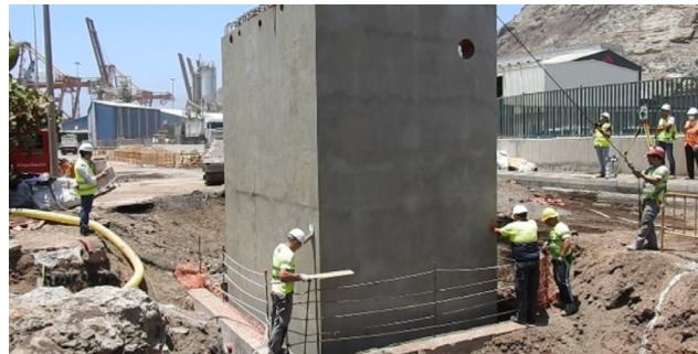
Obras dársena Santa Cruz de Tenerife
