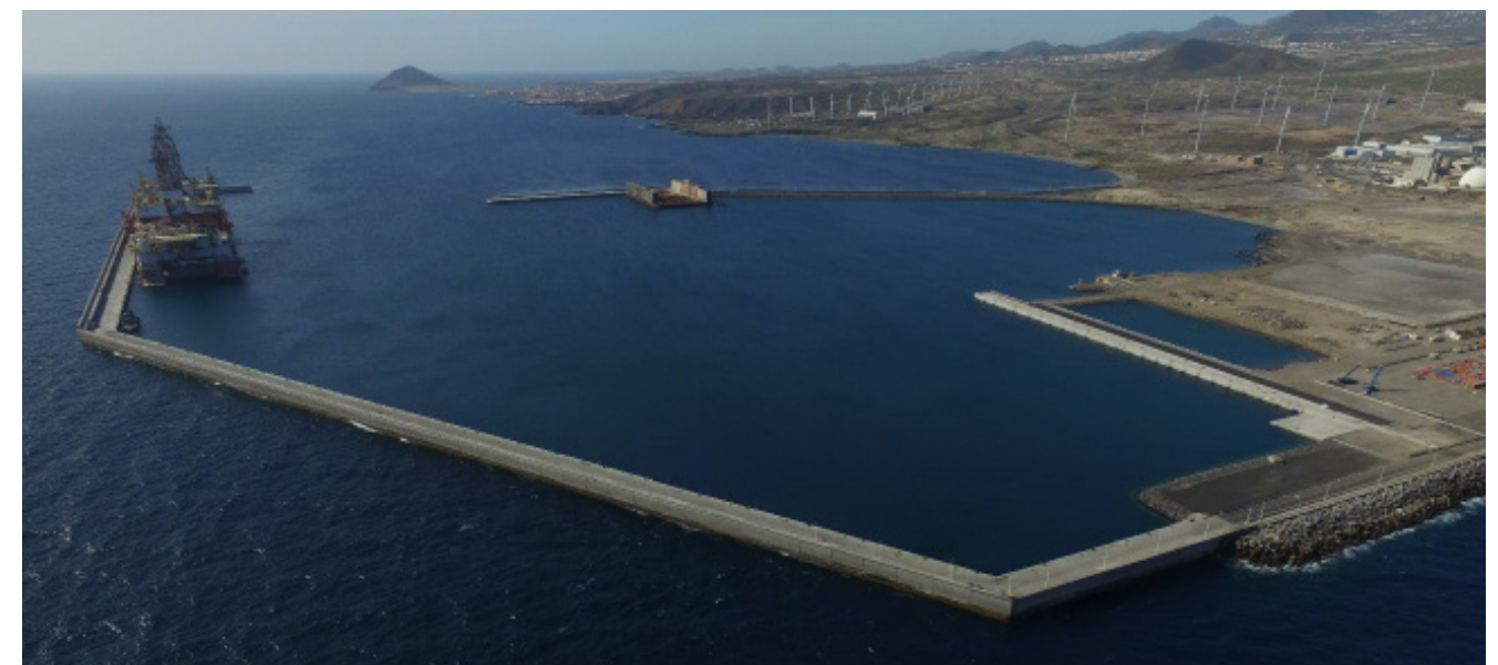
Relleno de Explanada en el muelle Polivalente del Puerto de Granadilla
