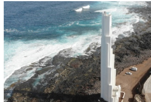
Rehabilitación del Faro de unta de Hidalgo
