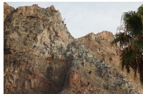
Tratamiento de ladera y canalización de desagüe en la zona de servicios portuarios de la Jurada
