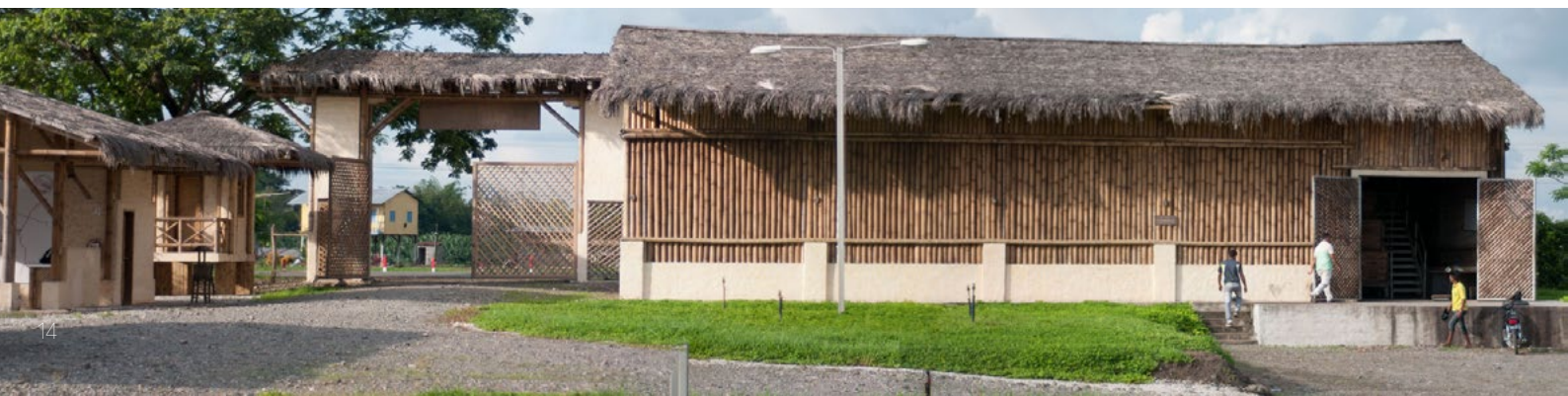
Centro de Acopio - Vinces
