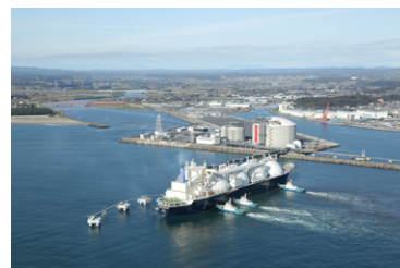
Hitachi LNG Terminal
