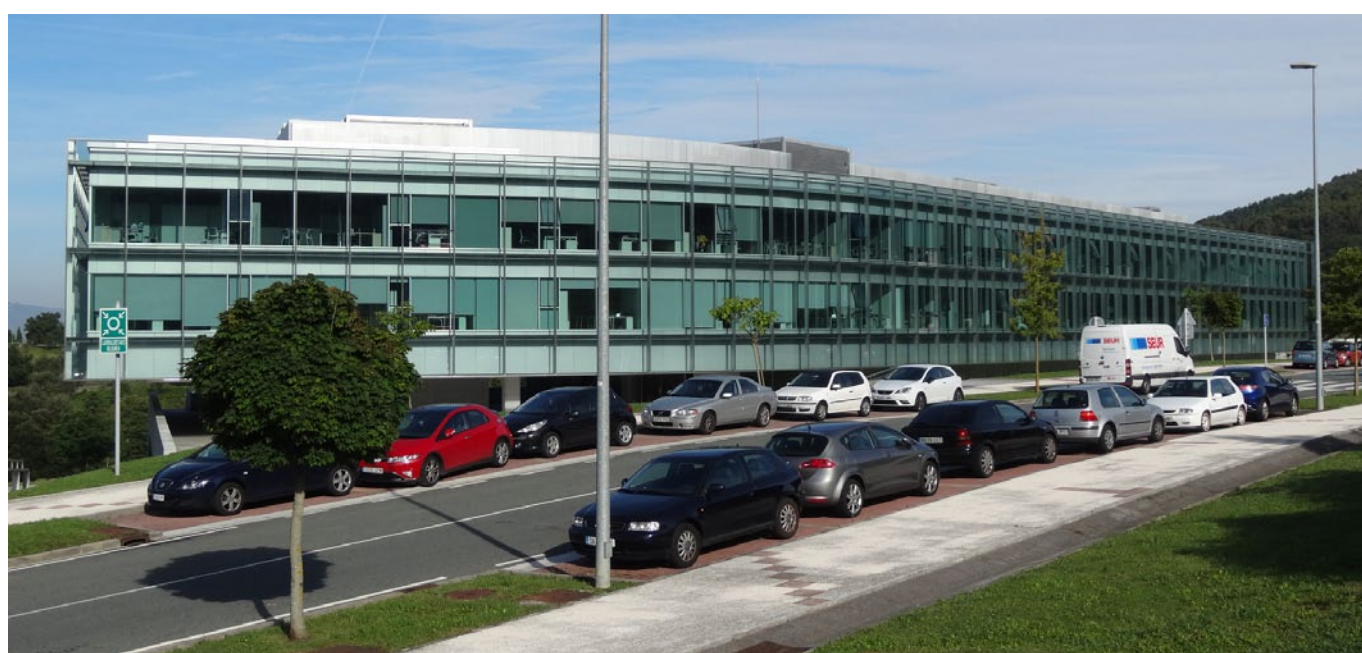
Oficinas centrales en Zamudio, Vizcaya
