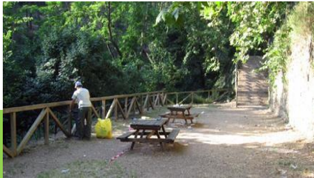
Adecuación de áreas de uso público
