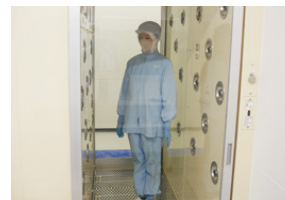
異物混入防止の対策(エアシャワー)
