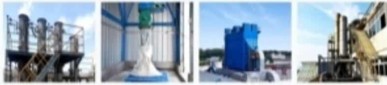
喷淋塔 (乙二醇: \leq 10\text{mg}/\text{m}^3 ) 袋式收尘 (颗粒物: \leq 5\text{mg}/\text{m}^3 ) 电捕焦油器 (油雾: \leq 6.2\text{mg}/\text{m}^3 ) VOC治理 (VOC: \leq 30\text{mg}/\text{m}^3 )
