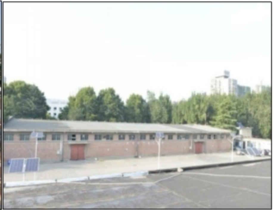
厂区太阳能路灯
