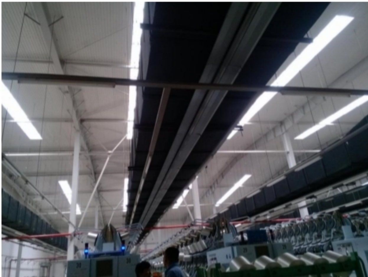
车间顶棚采用自然透光
