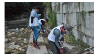
西日本豪雨で埋まった水路の土砂除去作業の様子
