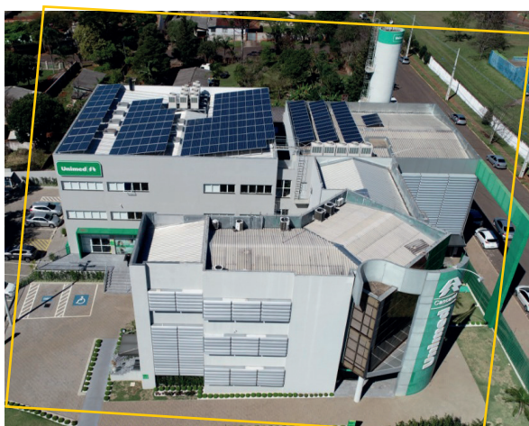
Placas solares fotovoltaicas instaladas na unidade sede
