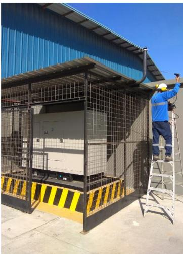
**Medición de gases a grupo electrógeno**
