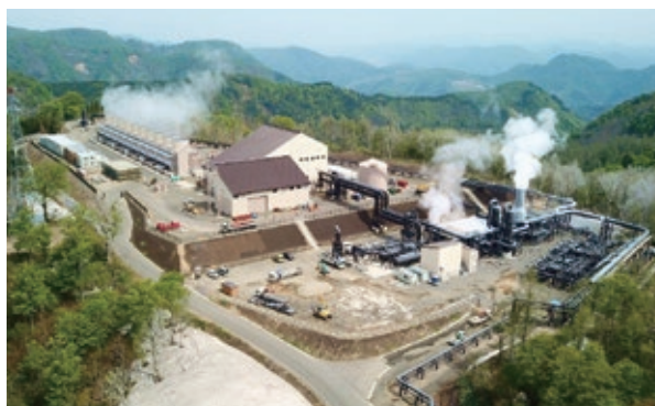
山葵沢地熱発電所(全景)
