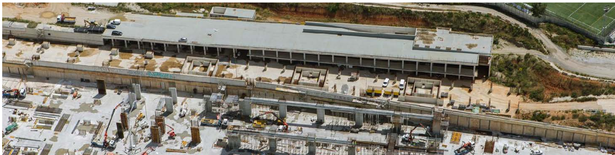
Construcción de la estación del AVE de La Sagrera, Barcelona (España).
