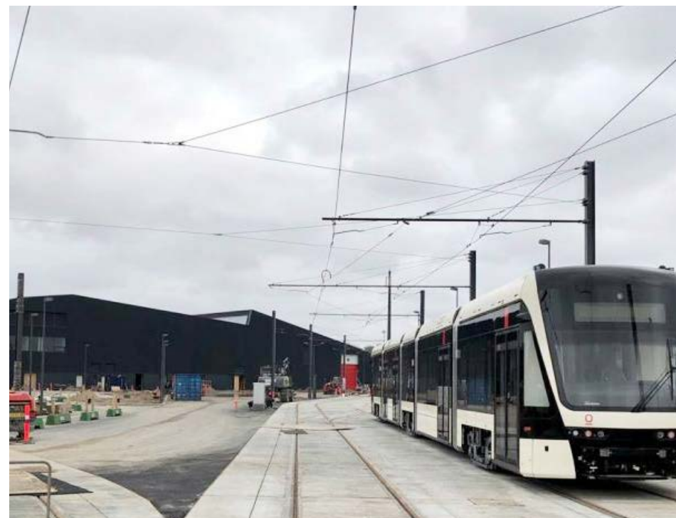
Tramo de tranvía en construcción, Odense (Dinamarca).
