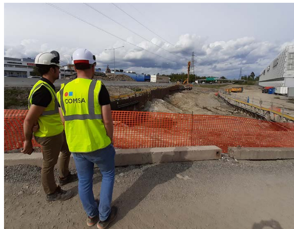
Construcción de dos túneles de acceso a la autopista E4, Estocolmo (Suecia).
