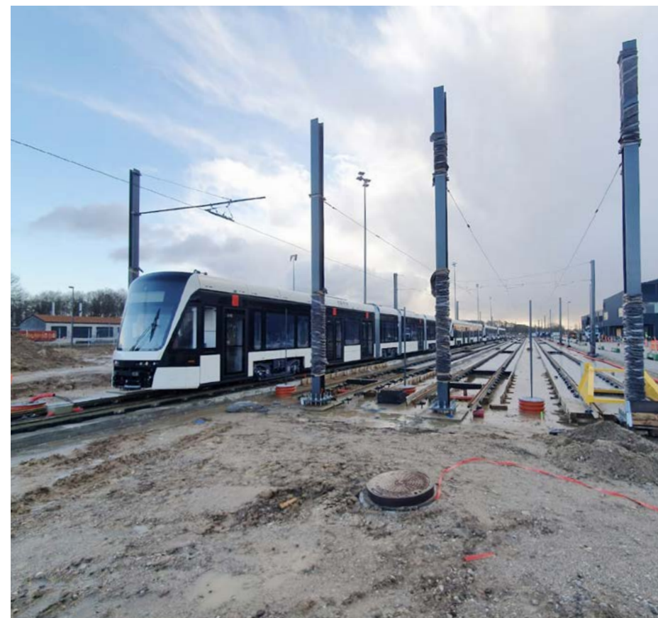
Tramo de tranvía en construcción, Tranvía de Odense (Dinamarca).
