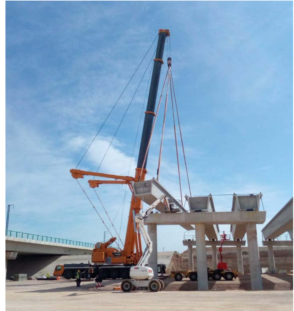
Construcción de la Autovía del Reguerón, Murcia (España).
