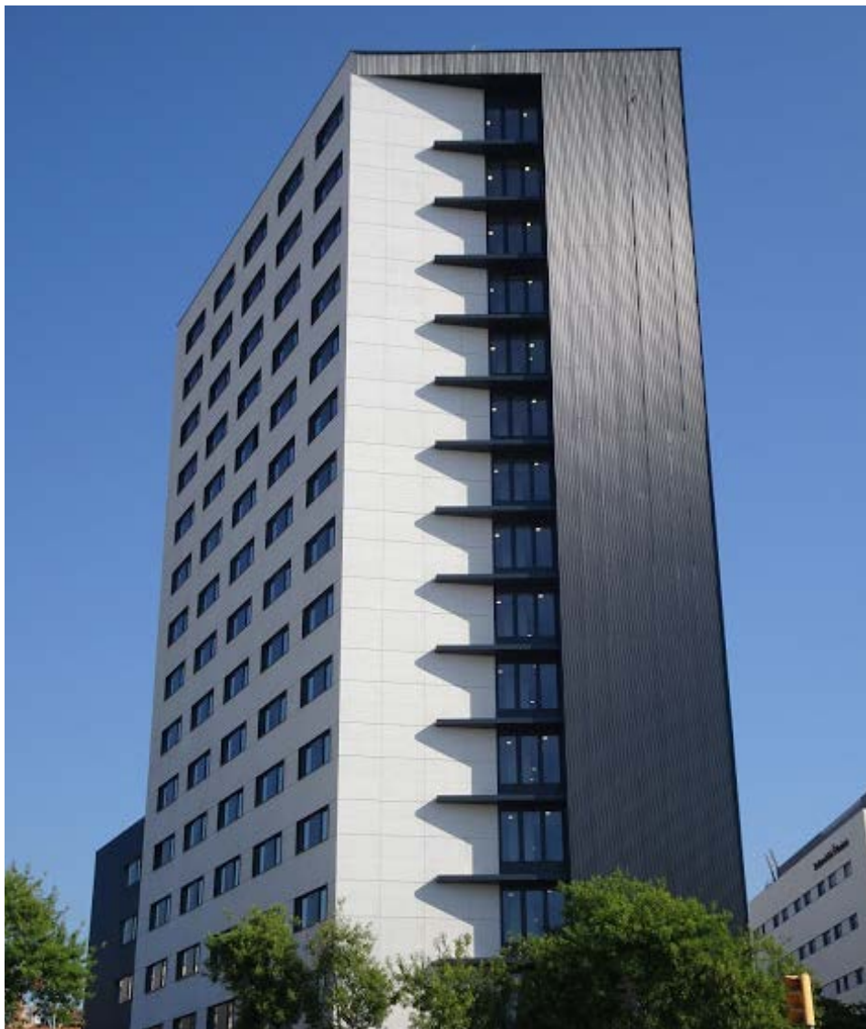
Construcción de la residencia de estudiantes contigua a la Estación de Sants, Barcelona (España).
