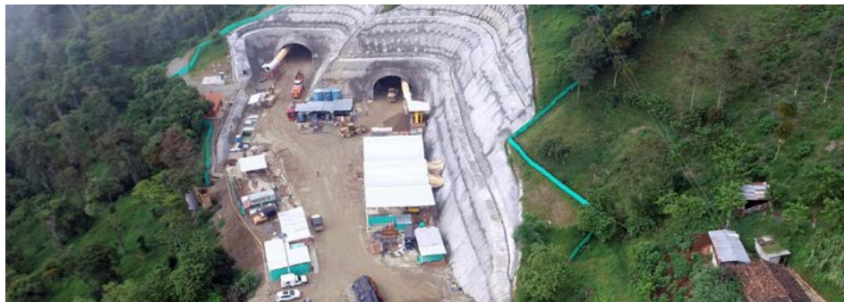
Construcción del Túnel de Amagá de la Autopista Conexión Pacífico 1, Antioquia (Colombia).
