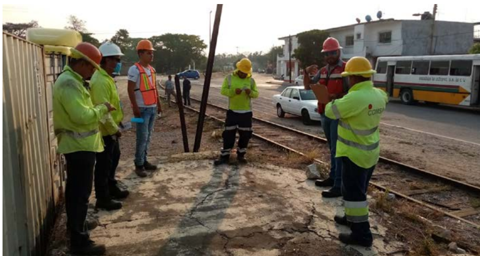
Mantenimiento de Línea A del Metro (México).
