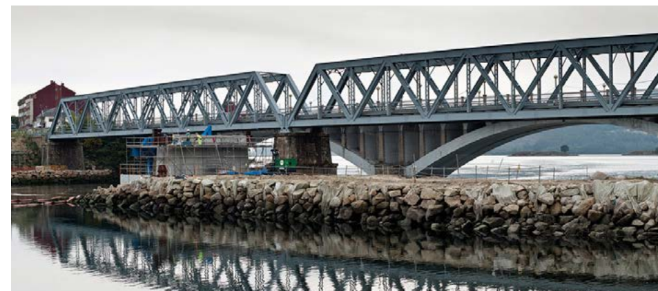
Construcción del tramo Soutomaior-Vilaboa del eje Atlántico de Alta Velocidad, Pontevedra (España).
