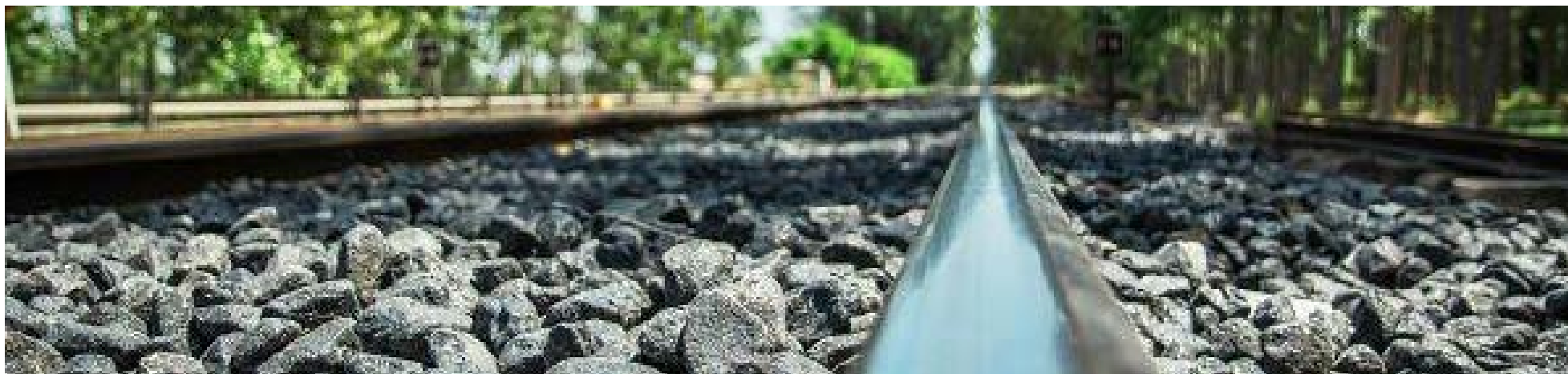
Sección de prueba de campo de Neoballast en el tramo Maçanet-Massanes y Caldes de Malavella, Girona (España).
