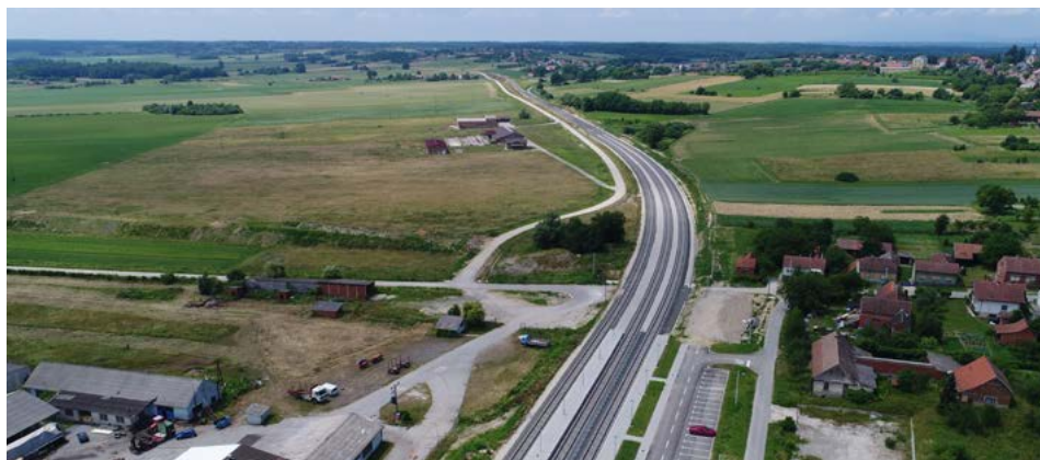
Nueva línea de ferrocarril entre Gradec y Sveti Ivan Zabno (Croacia).
