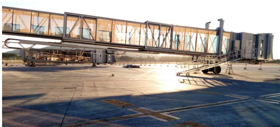
Instalación de pasarelas de embarque y equipos auxiliares para la Terminal 2 del Aeropuerto de Málaga-Costa del Sol, Málaga (España).
