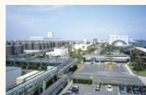
● サッポロビール千葉工場
