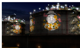
LNG Tank, Jeju Production Base
