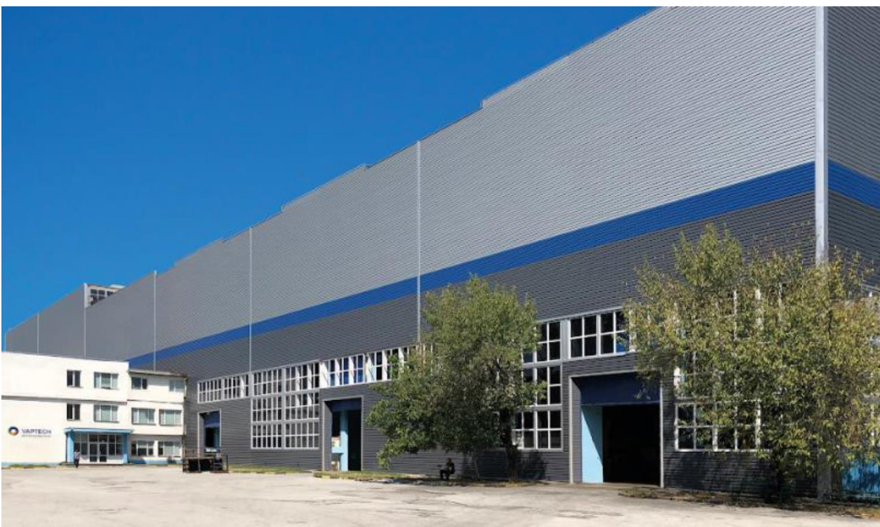
Обновената производствена сграда на ВАПТЕХ
