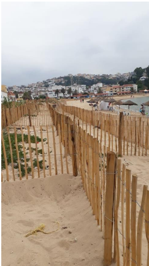
Travaux de protection du littoral contre l'érosion côtière par pose de ganivelles
