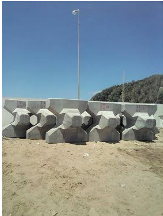
Travaux de réfection de l'épi du site les aiguilles à Tabarka par Acropodes
