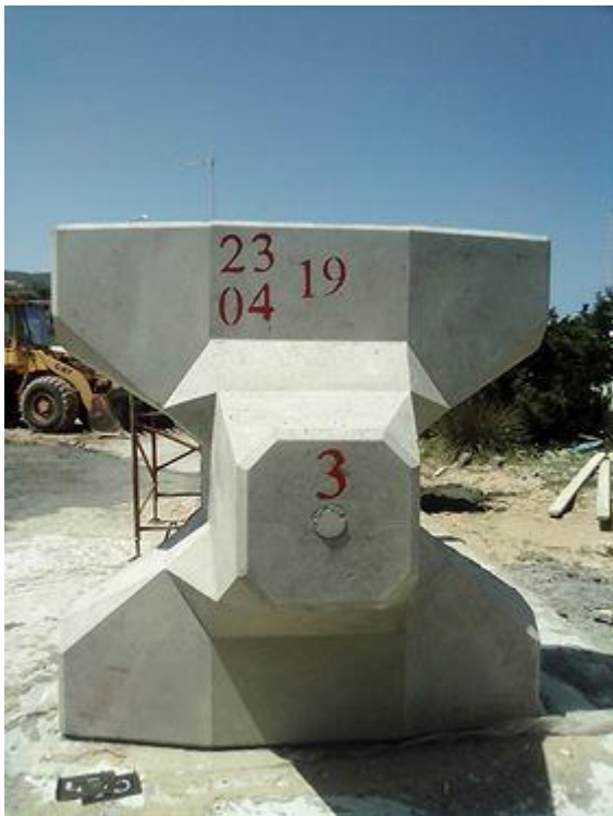
Travaux de réfection de l'épi du site les aiguilles à Tabarka par Acropodes
