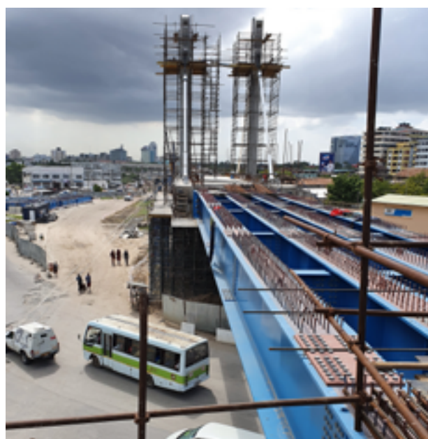
Infraestructuras ferroviarias diseñadas por TEC CUATRO en Tanzania
